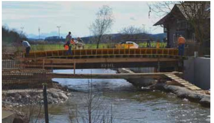
Im Jänner 2020 wurde mit dem ersten Abschnitt der Betonbauarbeiten begonnen. Dieser Abschnitt ist ein Projekt der Gemeinde Pfaffstätt und umfasst den Bau der Sportplatzbrücke und Abgänge für die Feuerwehr. Der Abbruch der Sportplatzbrücke ist bereits erfolgt und nunmehr wird eine neue Brücke errichtet. Diese wird etwas breiter sein und somit können auch Fußgänger bequem die Brücke überqueren.
