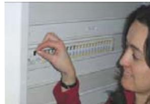
Alle Fehlerstromschutzschalter sind mit einer Prüftaste zum Funktionstest ausgestattet. Wird die Prüfung nicht durchgeführt, können die Kontakte verkleben. Ein Auslösen im Fehlerfall ist dann nicht möglich.
